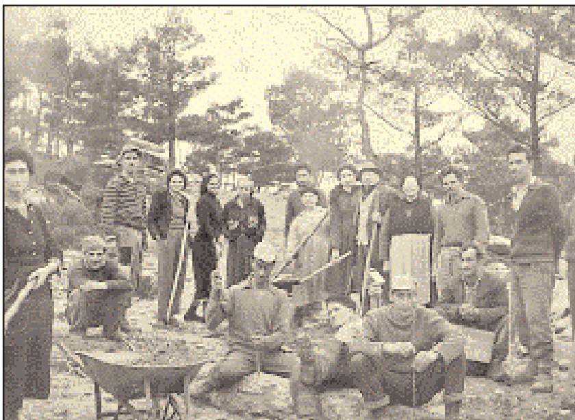
Κατασκευή δρόμου στο Μάραθο με εθελοντική εργασία των κατοίκων στη δεκαετία του '50. Το οδικό δίκτυο της Ικαρίας δεν έχει ολοκληρωθεί μέχρι σήμερα (φωτ.: αρχείο Αργ. Πάσχρη).
